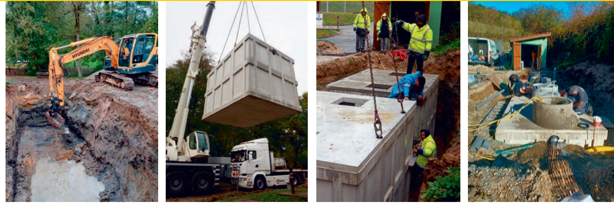
Mise en place par l'entreprise Da Cunha d'une micro-station Bionest répondant aux normes sanitaires pour une centaine de résidents en période de pointe.
